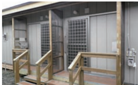
(上) 建設作業の様子 (下) 完成した応急仮設住宅
